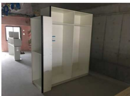
押入れ・物入れのユニット
