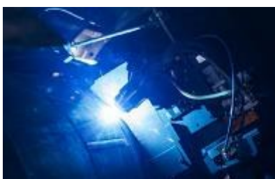
高速溶接技術
