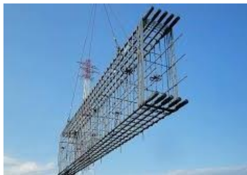
梁鉄筋地組取付
