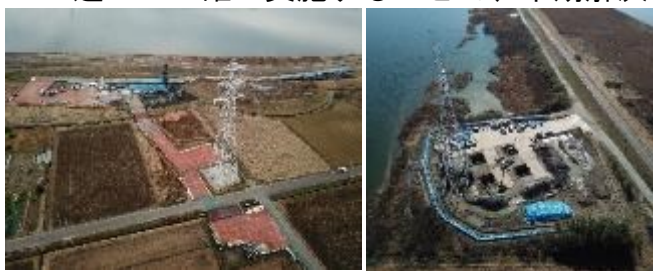
ドローン画像による現場状況確認
