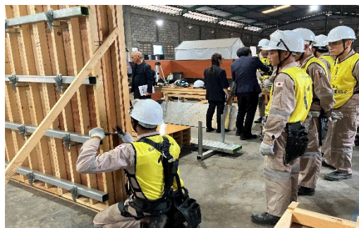
型枠施工実習風景
