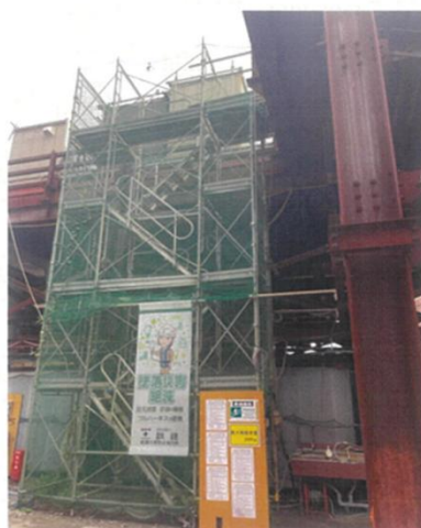
昇降設備全景
